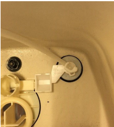
↑ Drej indløbs slangen inde i cisternen et lille hak til venstre
